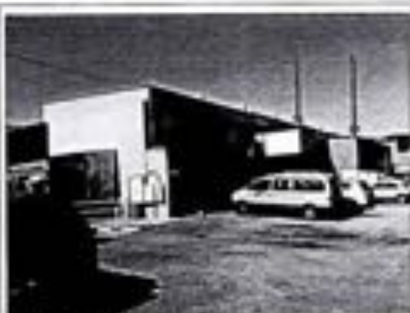
Fotografía N° 2: Ampliación irregular, bloque ceste general.
